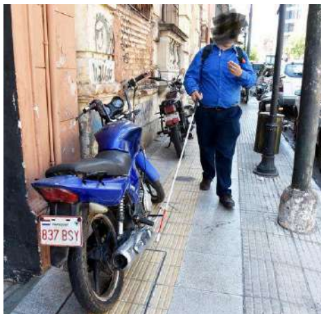
Imagen de motocicleta obstaculizando el pavimento podotáctil y mal estacionada en la pared, que debe quedar libre para el guiaje del bastón blanco.
